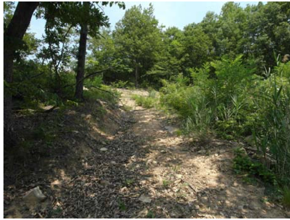
상부 비탈면 및 수목 상태
