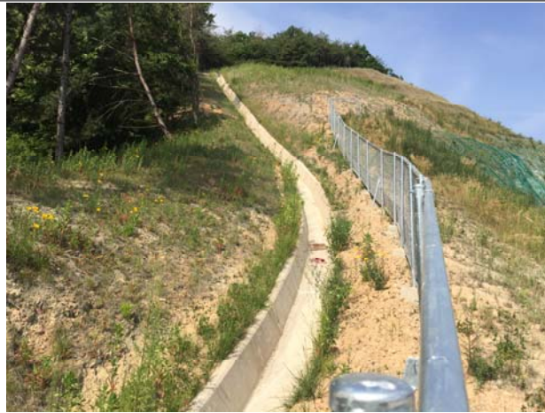
상부 비탈면 및 수목 상태
