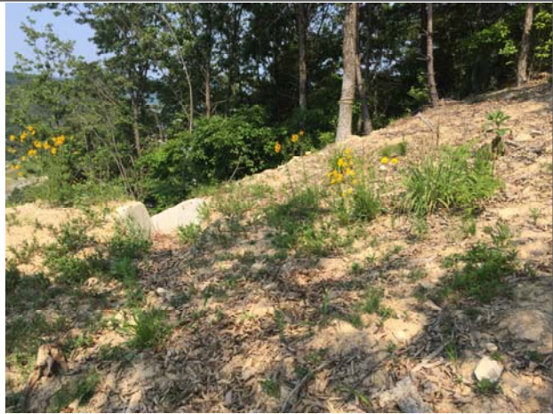
상부 비탈면 및 수목 상태
