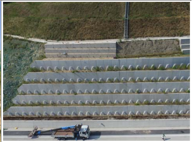
사면 보강공(절토부옹벽) 시공상태
