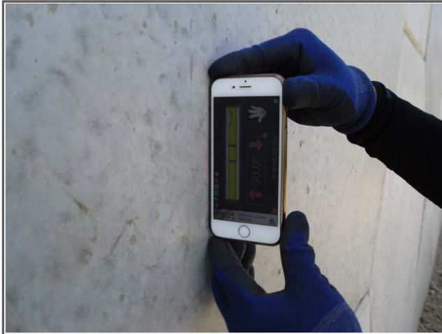
내 용 옹벽 기울기 측정
