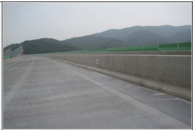
내 용 중앙분리대 시공현황 - 양호
