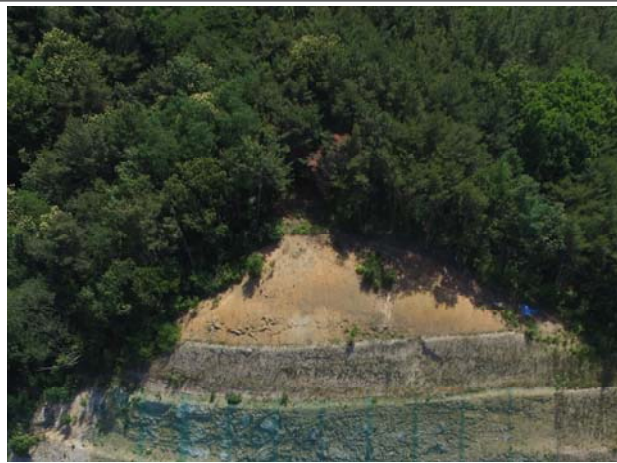
상부 비탈면 및 수목 상태
