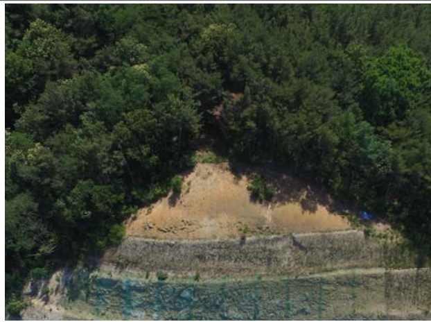
상부 비탈면 및 수목 상태
