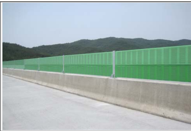
내 용 방호벽 및 방음벽 시공현황 - 양호
